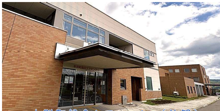
本別町総合ケアセンター（外観）
